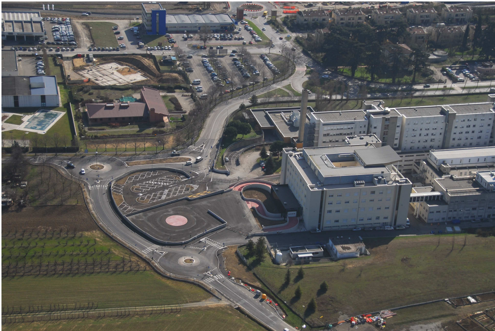
Figura 7.1 - Ospedale di Imola Nuovo Dipartimento di Emergenza e Accettazione
