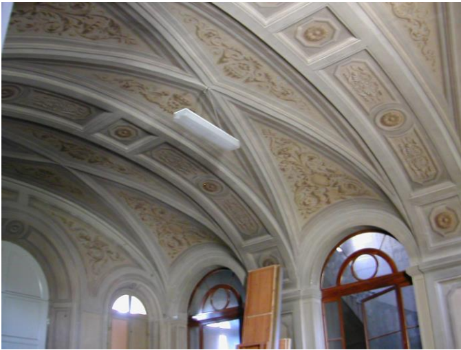
Fabbricato della direzione - piano terra: atrio principale
