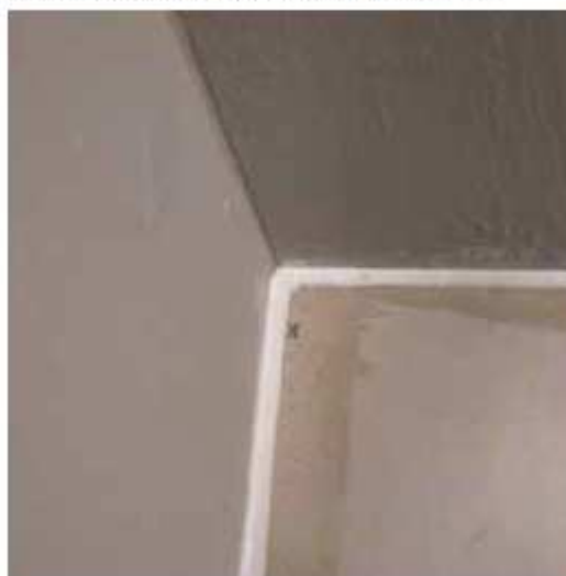
STUCCATURA DEI GIUNTI TRAMITE MASTICE ACRILICO VERNICIABILE
