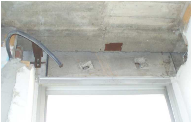
FOTO 2 PARTICOLARE HALFEN ESISTENTI AGGANCIO SUPERIORE A SOLAIO
