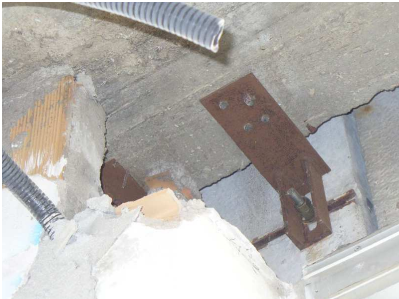
FOTO 2 PARTICOLARE HALFEN ESISTENTI AGGANCIO SUPERIORE A SOLAIO
