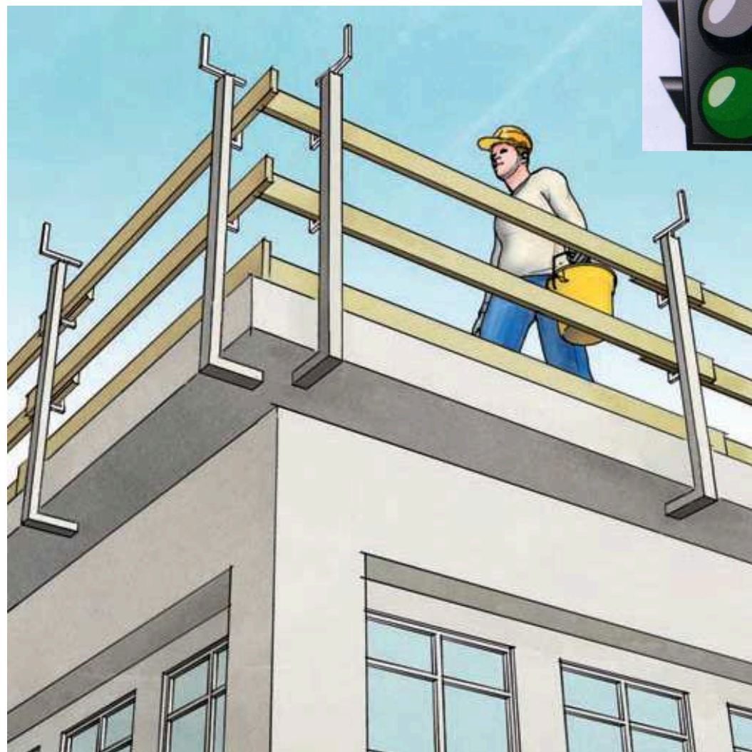
Parapetto provvisorio del tipo a morsa.
