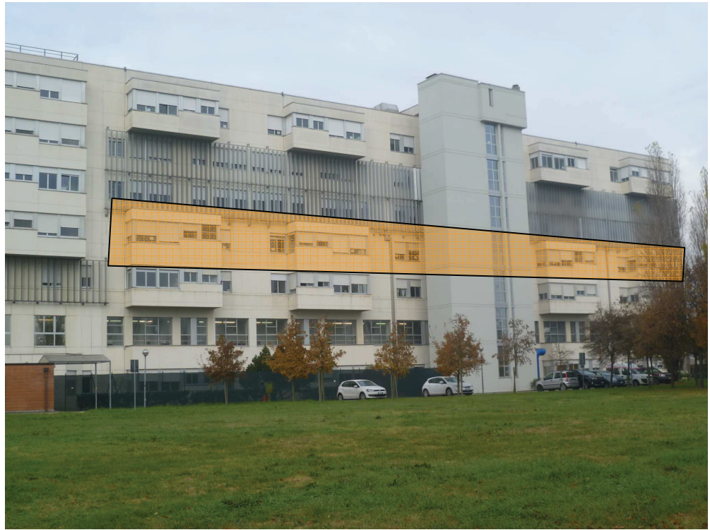
Vista esterna area intervento
